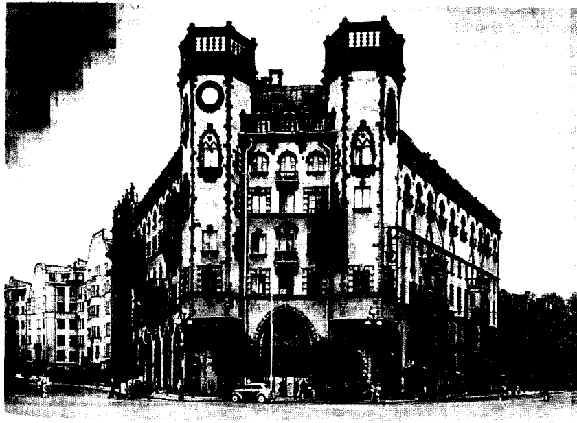
А. Е. Белогруд. Доходный дом К. И. Розенштейна на Архирейской площади (ныне пл. Л. Толстого). 1913—1917. Санкт-Петербург
